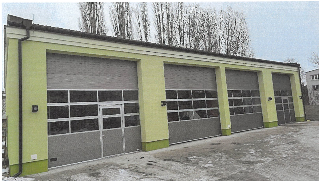
Fot. Budowa nowego budynku magazynowego, Źródło: materiały własne KM PSP w Piotrkowie Tryb.
