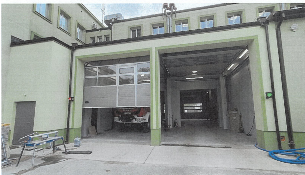
Fot. Rozbudowa garażu głównego o dodatkowe stanowiska garażowe, Źródło: materiały własne KM PSP w Piotrkowie Tryb.
